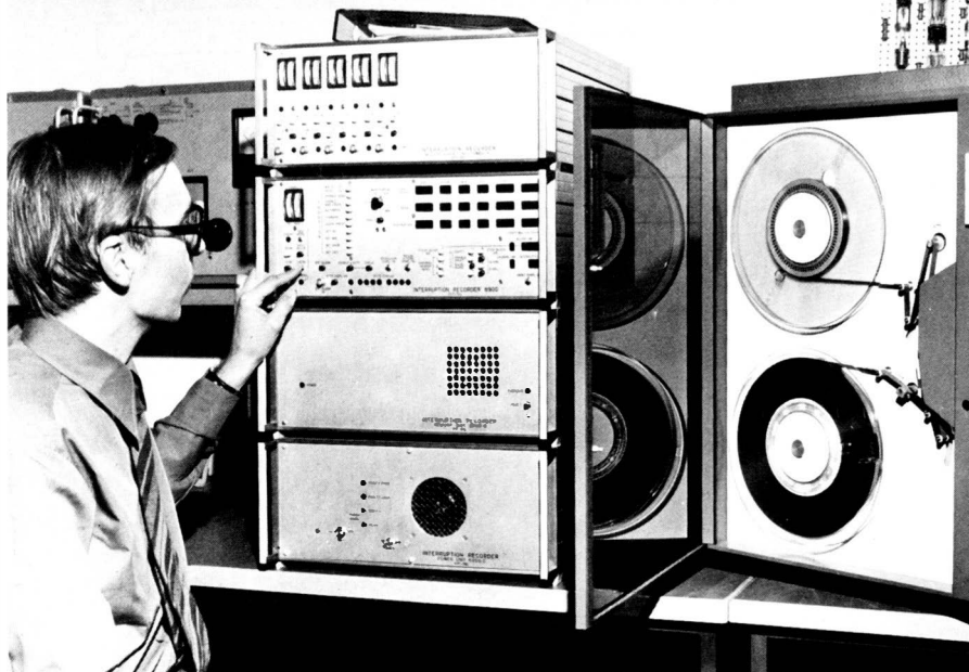
VTT:n teletekniikan laboratoriossa kehitetty laitteisto tietoliikenneyhteysien siirtokatkosten rekisteröimiseksi.
